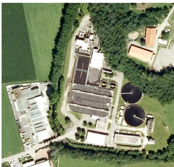
FIGURA 14: DEPURATORE CONSORTILE IN COMUNE DI BULGAROGRASSO
