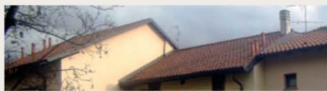
Rifacimento della copertura in coerenza con il contesto, con l'utilizzo di coppi
