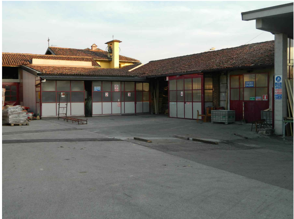
FOTO STATO DI FATTO
