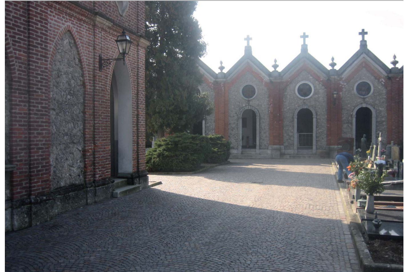
LATO OVEST - CAPPELLE PRIVATE
