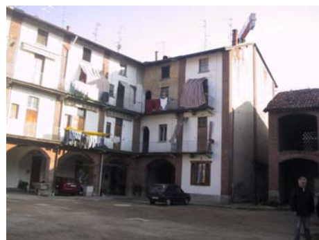
Casa operaia- cortile interno
