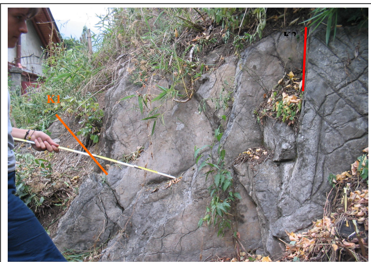
Particolare dell'area d'indagine, ove sono ben visibili le famiglie di discontinuità individuate nel rilievo geomeccanico
