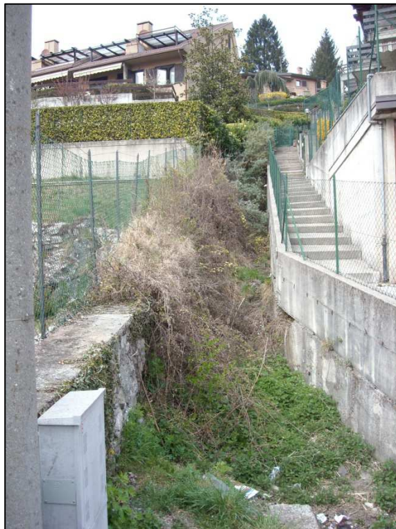
FOTO 17: Torrente n° 17D – Alveo incanalato asciutto
