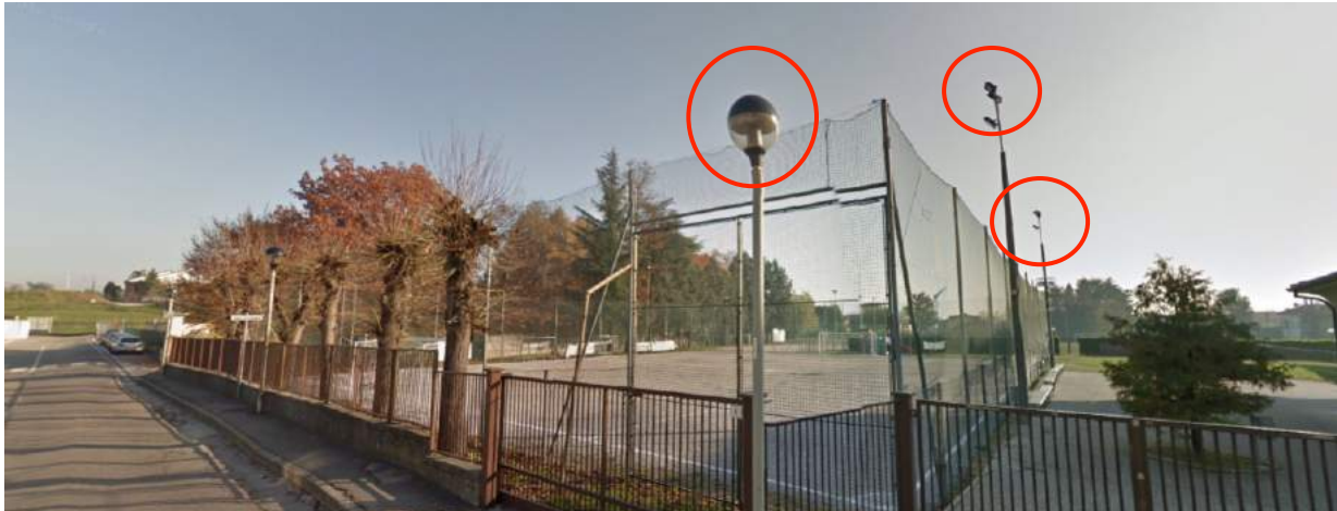
Figura 63. Area d'interesse pubblico di Arosio con illuminazione privata/pubblica non conforme a causa del corpo lampada che in questo caso proietta a 360°. Fonte: elaborazione personale.
