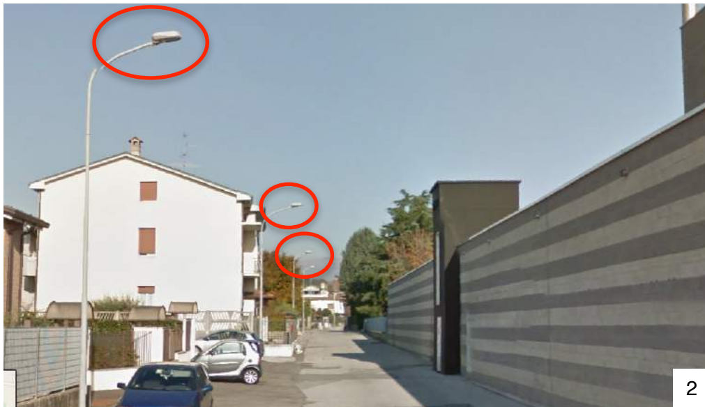
Figura 34. Zona industriale di Arosio con illuminazione non conforme a causa dell'inadeguata inclinazione del supporto della lampada oltre i 90°C, che provoca il rischio di abbagliamento degli utenti. Fonte: google maps.
