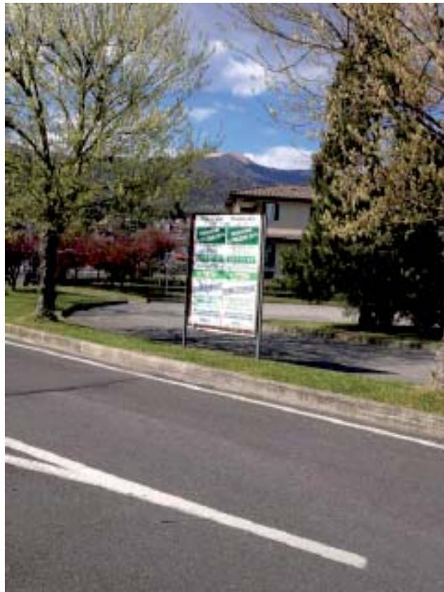
Struttura in acciaio verniciato completi di due montanti e una cornice contenente la lamiera per affiggere i manifesti. Tutto il materiale dovrà essere zincato o elettrozincato. Gli impianti per le affissioni dovranno essere progettati, realizzati e posati in opera in modo tale da non arrecare pericolo o disturbo alla sicurezza stradale, sia veicolare che pedonale.
