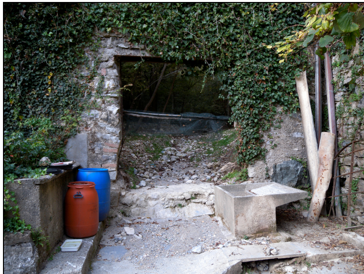
Foto 4. Il passaggio verso il tratto canalizzato a monte di via Cadorna con detriti lapidei trasportati dalla corrente in occasione delle piene
