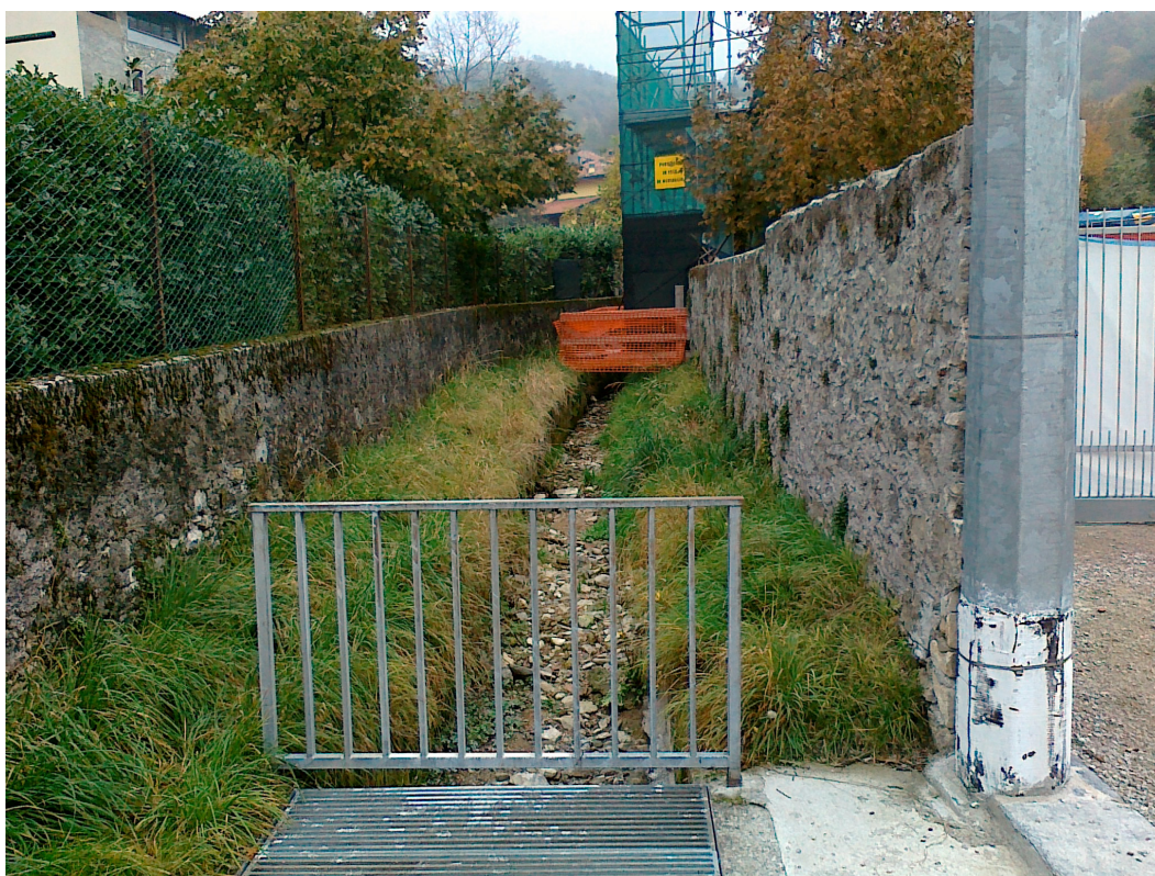
Foto 5-6 Sezioni di tombinatura di corsi d'acqua al raccordo tra la zona collinare e l'area di pianura
