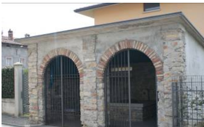
Figura 7 - Il Lavatoio di Saruggia
